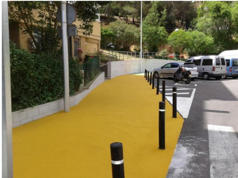
Ilustración 49. Diferencias en el pavimento mediante la textura y el color.
