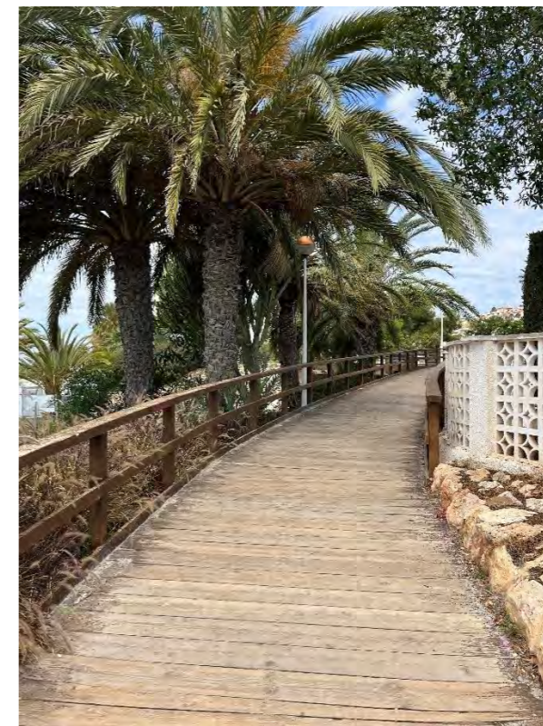
Ilustración 44. Paseo Vicealmirante Blanco. Fotografía propia
