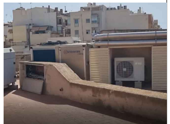
D04_ Demolición murete
