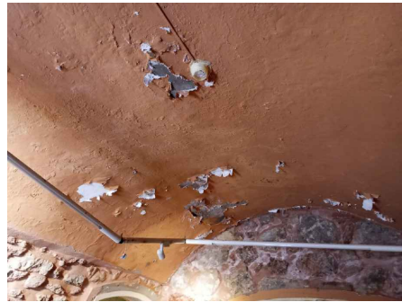
ENTRADA DE AGUA / HUMEDADES EXISTENTES
