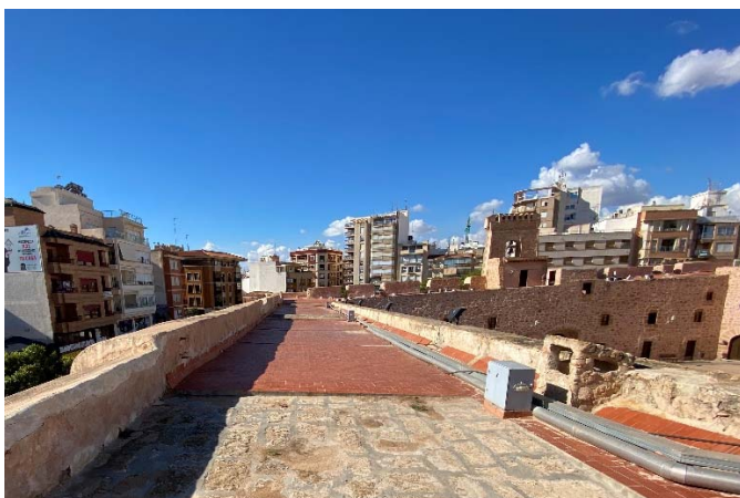
Presencia de instalaciones en cubierta
