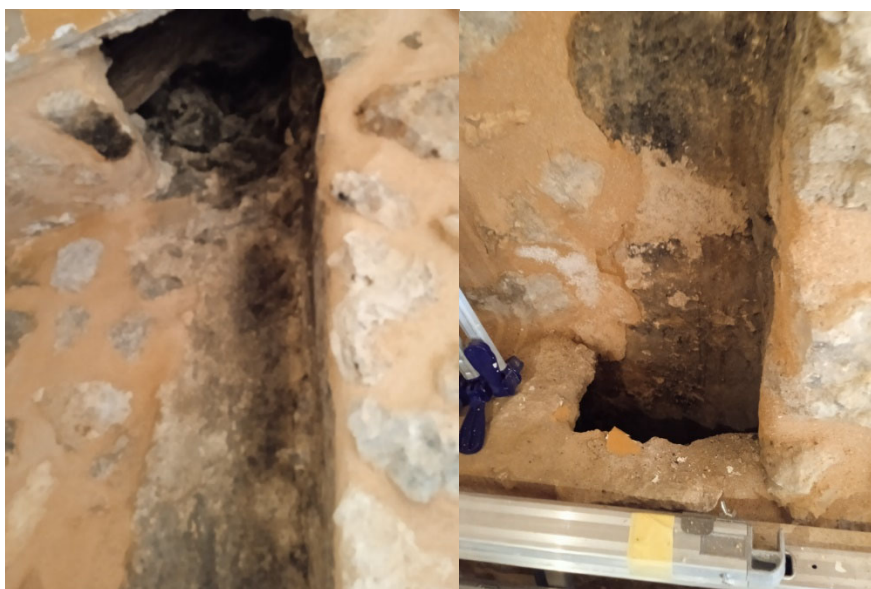
Imagen de antigua chimenea donde aún puede apreciarse el hollín.
