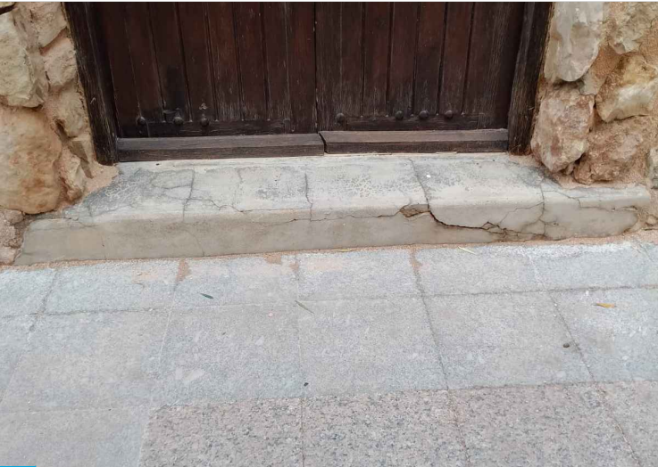
Estado actual escalón de acceso
