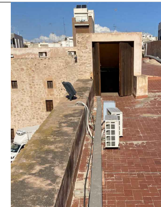
1) Canaleta a desmontar
